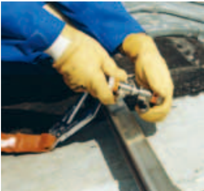
可拆卸式滑梭可以通过旋钮在任意点与系统连接，
